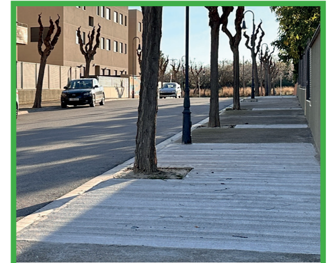
ARRANJAMENT DE LES VORERES A LA BARQUERA.
