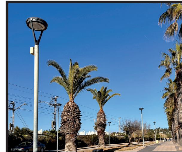
RENOVACIÓ DE L'ENLLUMENAT PÚBLIC EN DIFERENTS BARRIS.
