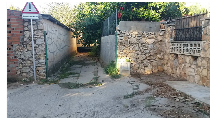
ENCONTRE DE L'ESCORRENTIA AMB EL CAMI DE BARÀ
