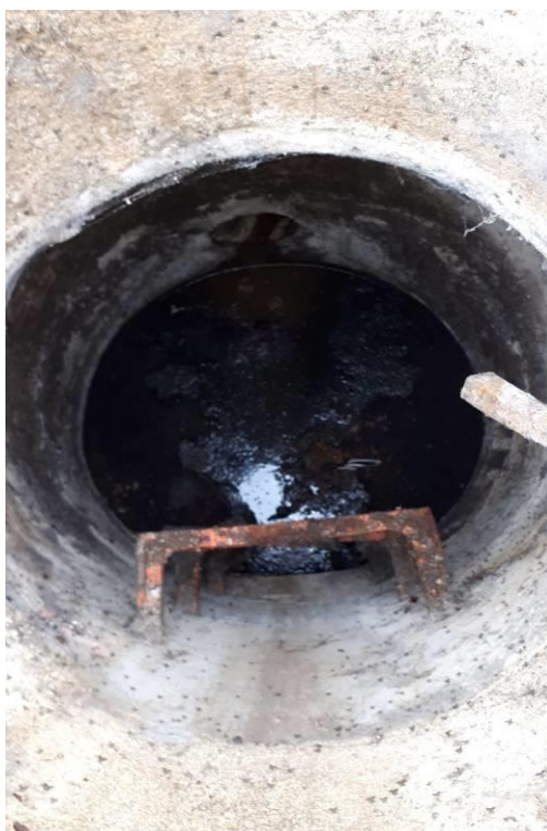
Pou de final del clavegueram existent.
