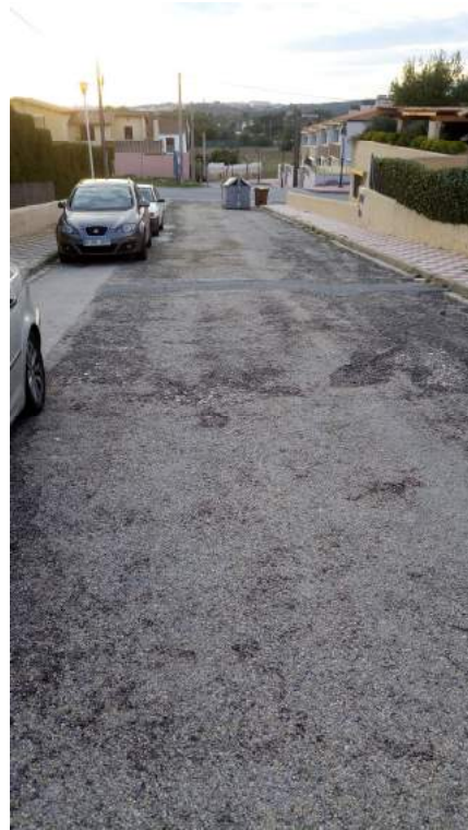
Capa de rodadura molt deteriorada, esquerdada, flonjalls localitzats
