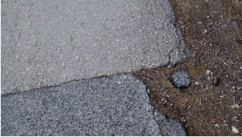
Desperfectes puntuals de la capa de rodadura en encontres d'actuacions diferents
