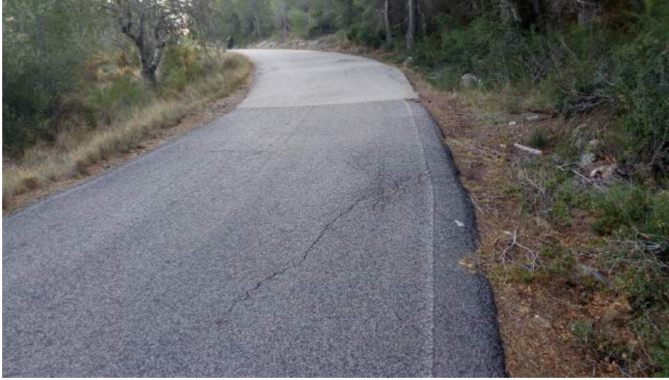
Capa de rodadura esquerdata
