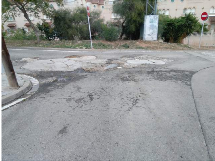
Trams amb capa de rodadura esquerdada i talls de rases anteriors
