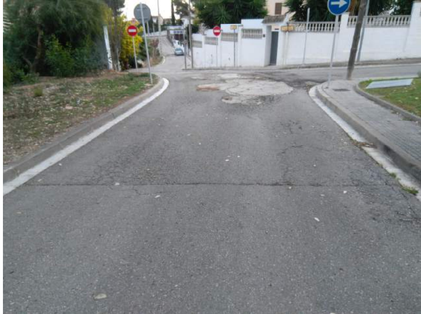
Capa de rodadura trencada i amb pell de cocodril
