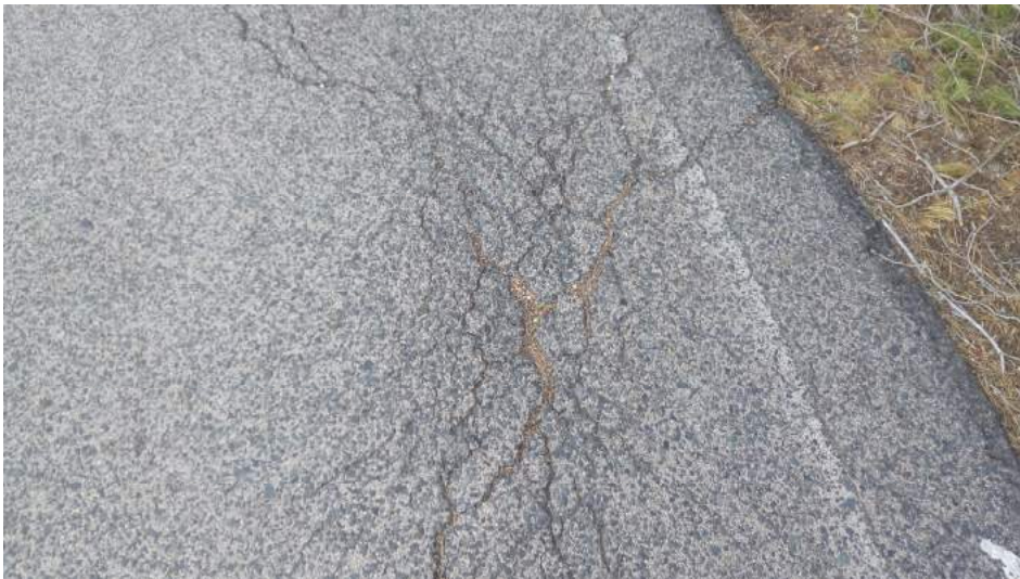
Capa de rodadura esquerdata i pell de cocodril
