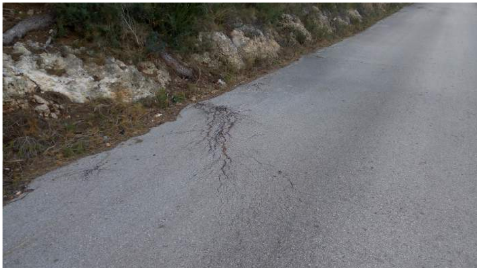
Bonys en laterals i capa de rodadura esquerdata
