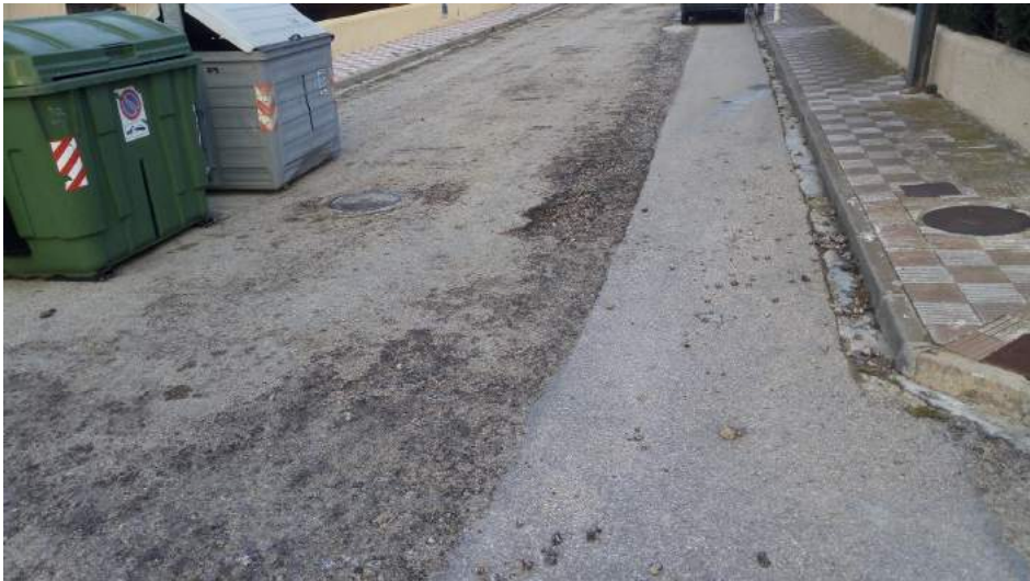
Capa de rodadura molt deteriorada i rasa al lateral dret
