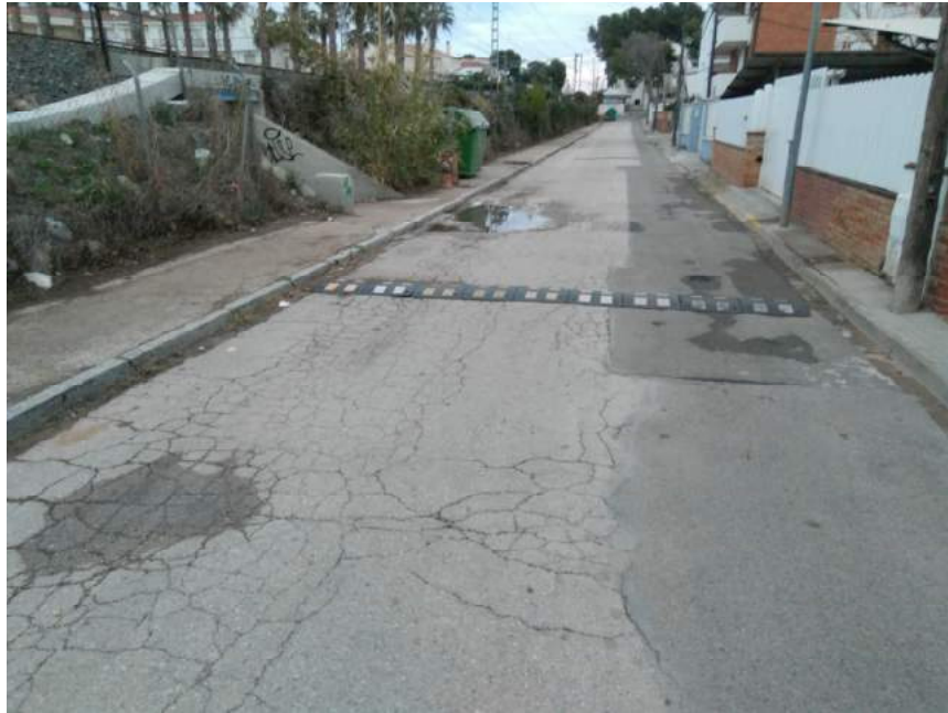
Capa de rodadura esquerdada i flonjalls
