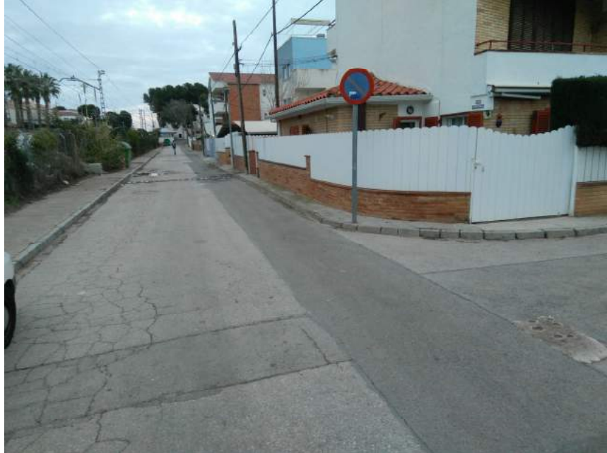
Capa de rodadura esquadada i amb pell de cocodril
