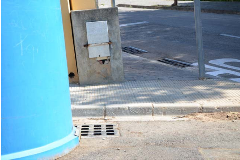
Detall de l'embornal al final del C. meritxell, cantonada Fleming
