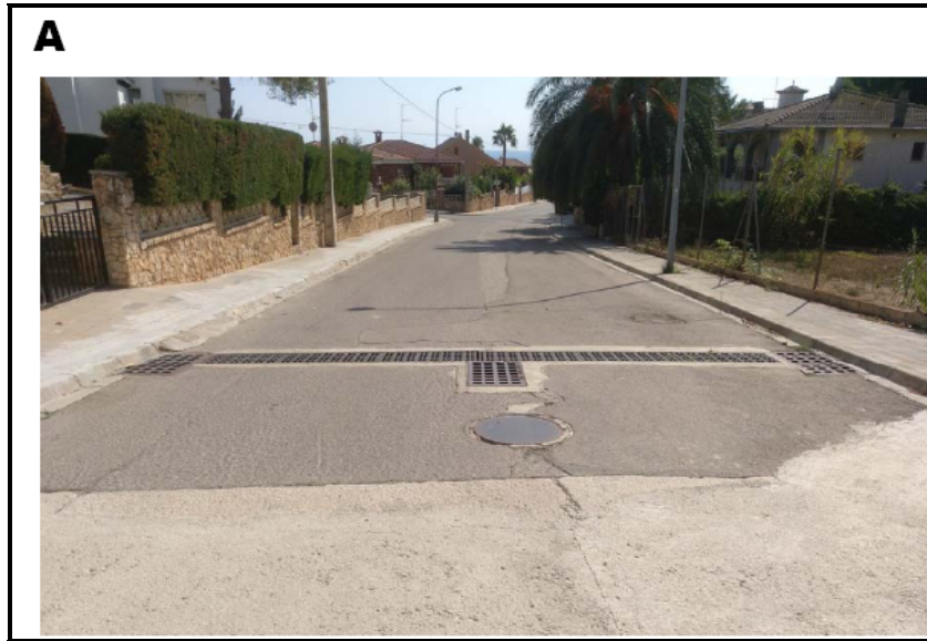
Pk de connexió del C. J.S. Bach amb el seu tram precedent.
