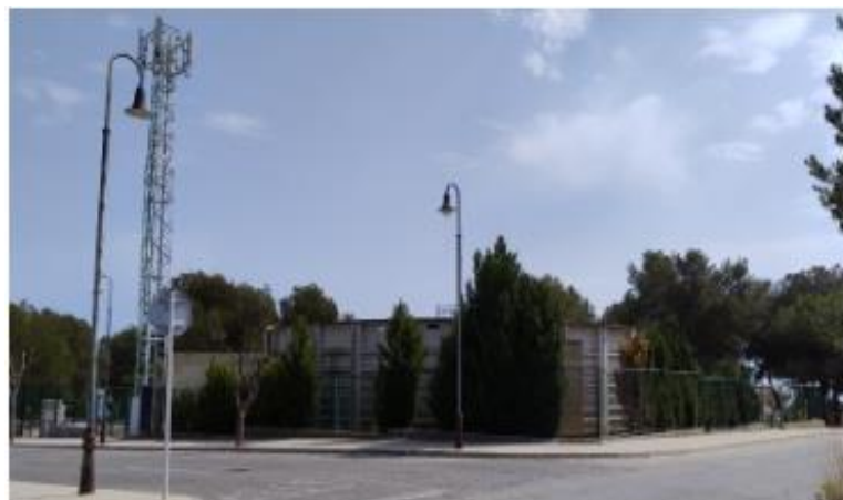
Imatge 12: Dipòsit Francaset
