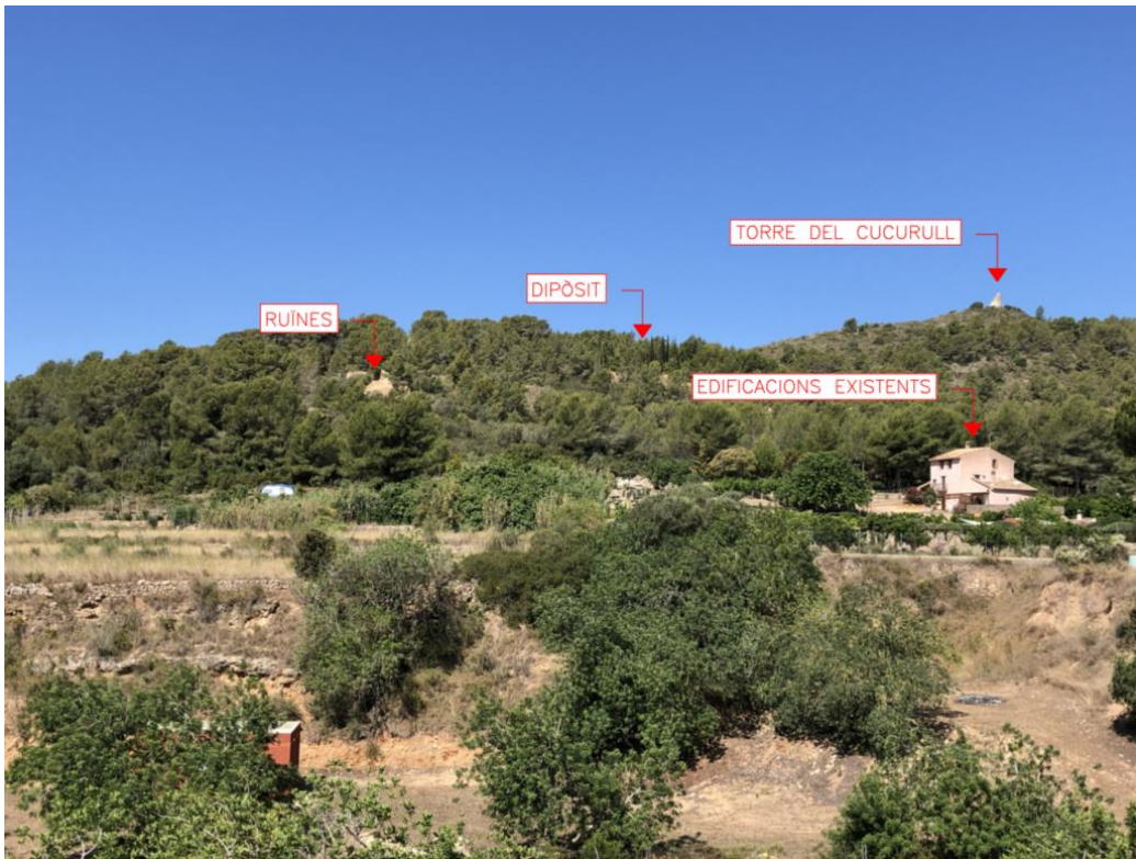
Visual 4. Visual del dipòsit des de C. de Vila-rodona (Roda de Berà). Vessant Est
