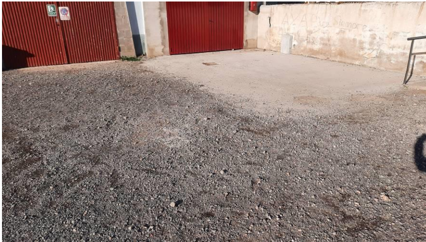
Zones pavimentades amb una solera de formigó.
