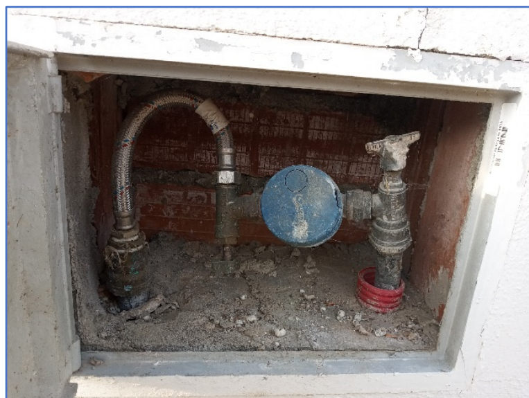
Figura 4: Interior de l'arqueta de cabalímetre
