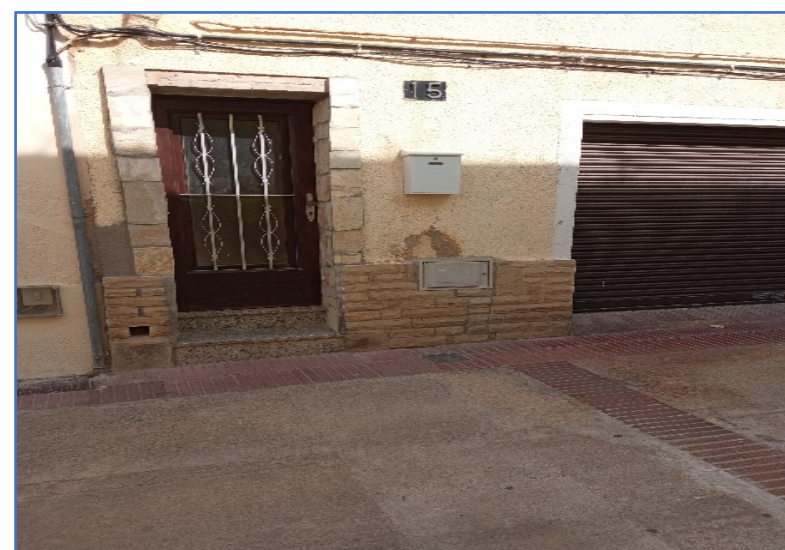
Figura 4: Armari i Escomesa tipus al c/ Montjuic (nº15)
