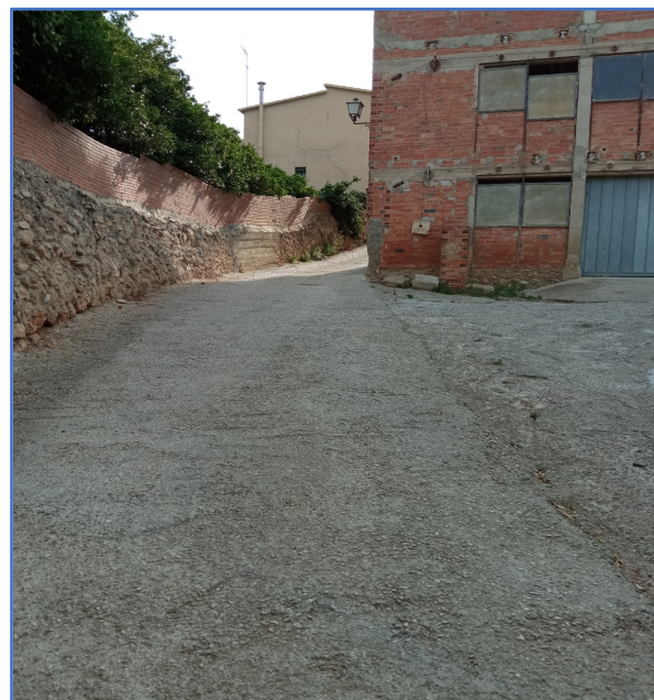
Figura 13: Continuació c/ Valls (formigó)
