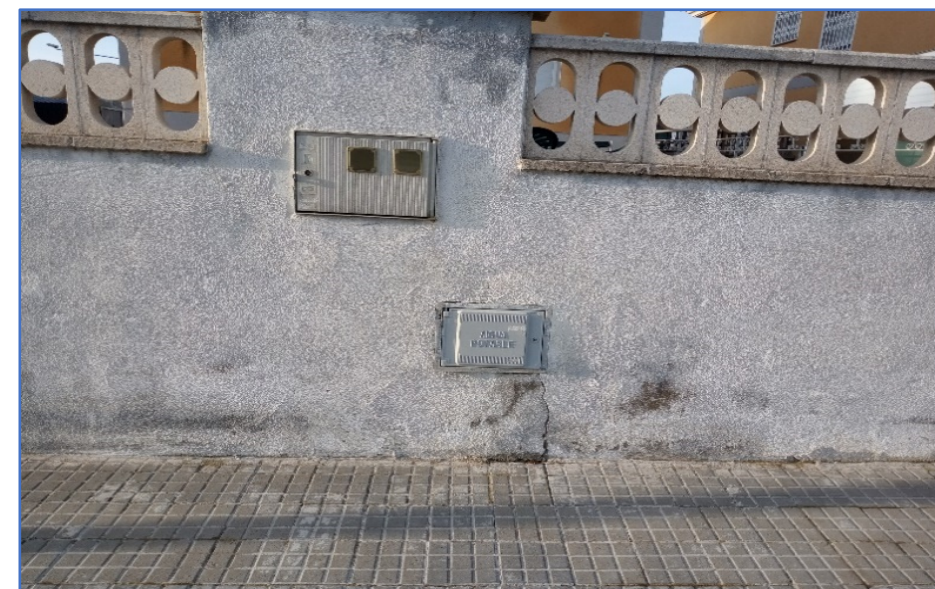
Figura 3: Arqueta de cabalímetre existent Urbanització Baramar
