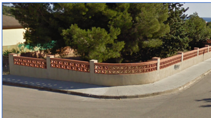
Figura 5: Punt de connexió del c/ Cranc (Nº senars) amb canalització existent c/ d'Aries
