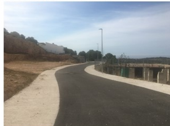
Foto 4: Imatge del carrer de Johann Sebastian Bach urbanitzat i les construccions de l'entorn inacabades i abandonades.
